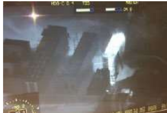
Fig. 4: Thermografie om de evolutie van de temperatuur in de container te controleren.
