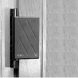
Bild 3-26: Bandseitensicherung
