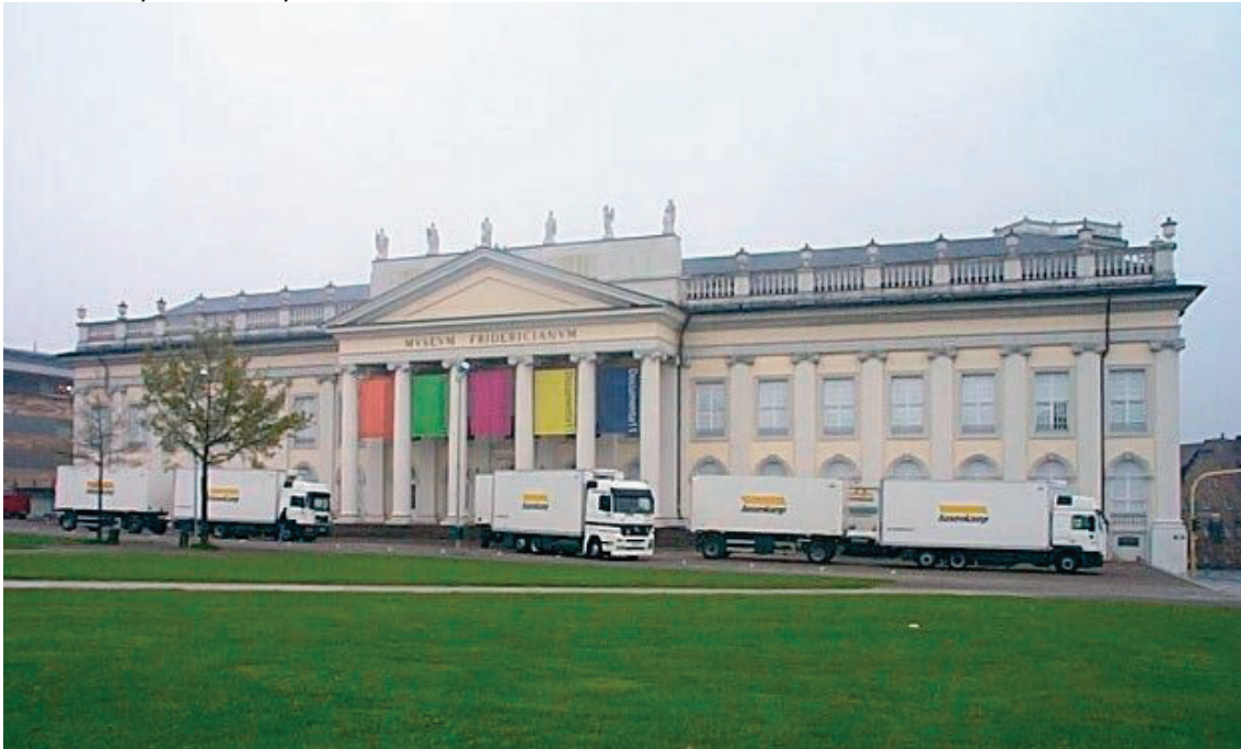
Figure 4 Courtesy of hasenkamp Internationale Transporte GmbH
